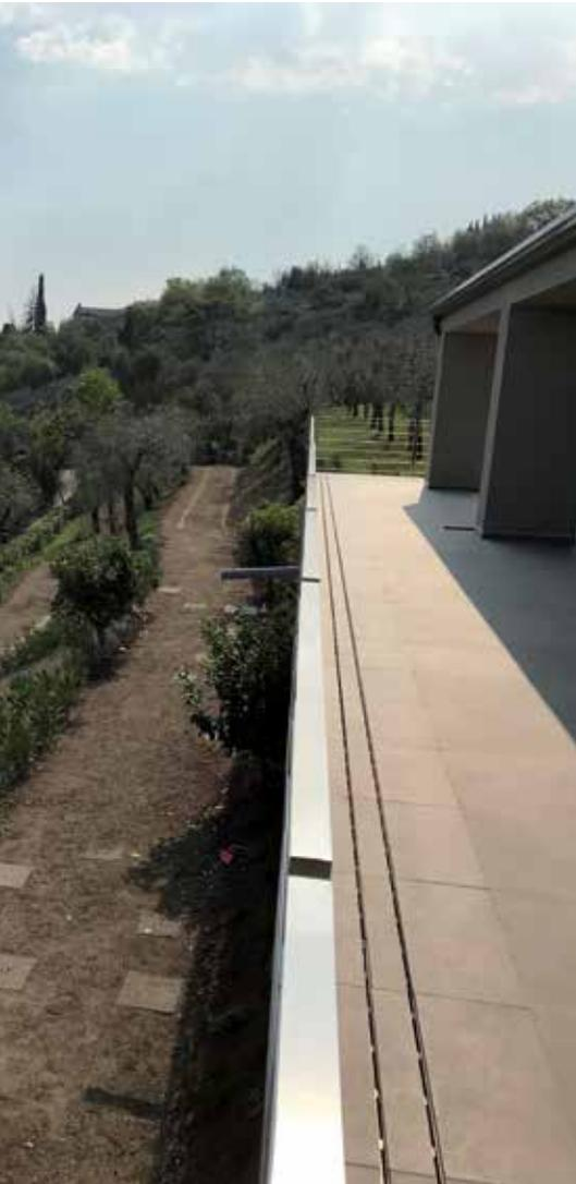
CANALINAINFINITY y TECNOCHANNEL son sistemas avanzados de drenaje lineal estancos al 100% que permiten la evacuación de las aguas superficiales. Son aptos para estructuras pavimentadas en ambientes internos y externos.
